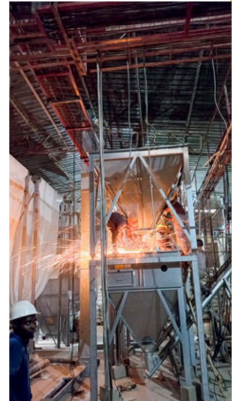
L'usine en pleine rénovation.
